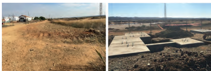
Figura 10: Detalles de la ejecución de la obra con ensanchamiento del camino, y estructuras de hormigón de las zapatas de la pasarela.
