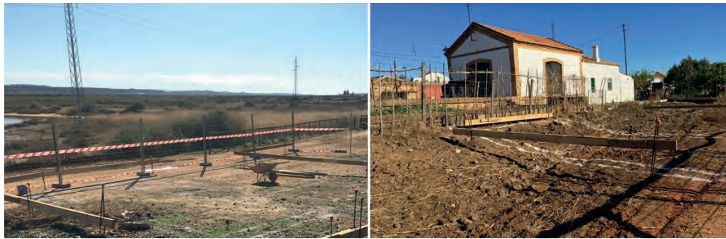
Figura 4: Replanteo de las zapatas y zunchos en la Zona 1.
