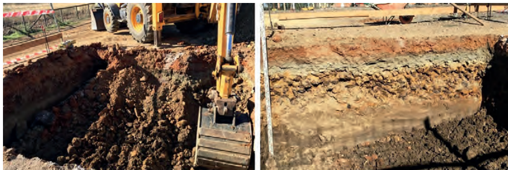
Figura 7: Apertura de la zapata 4 en la Zona 1 donde se aprecia en el perfil Norte la Unidad Estratigráfica de minerales de pirita.
