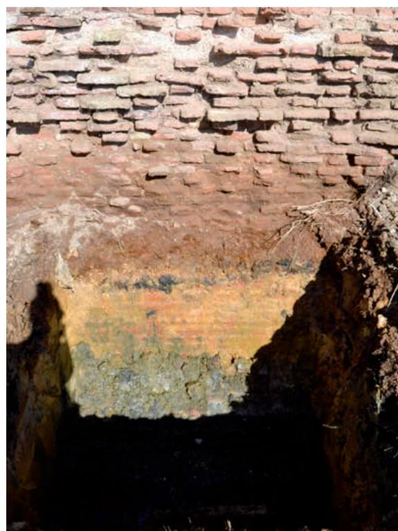
Figura 3. Sonda al interior en el que se observa la zapata y el muro. Corte en el exterior donde se aprecia el diferente grado de conservación
