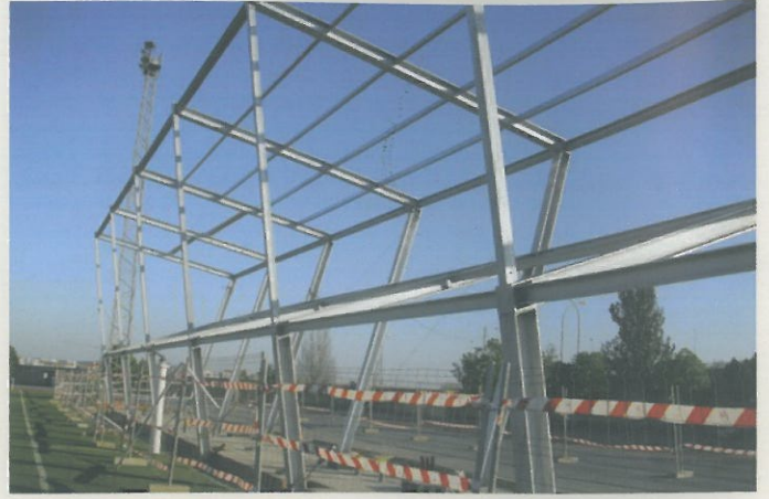
Las obras del graderío del campo de fútbol se iniciaron en el pasado verano
