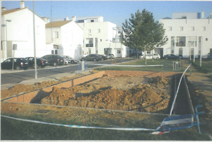
La asociación vecinal Los Pintores vio cómo comenzaron las obras de su nueva sede
