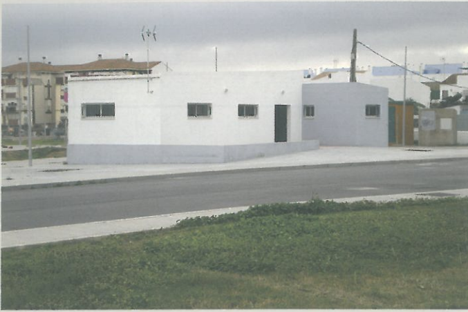
Culminaron los trabajos de la sede de la Asociación de Vecinos de Celulosas
