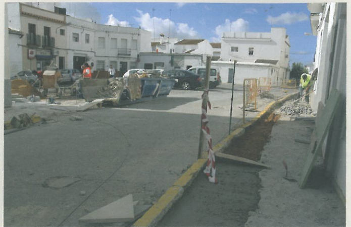
En noviembre este era el aspecto que presentaba la Plaza de los Toros con las obras del Plan Proteja
