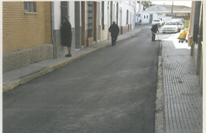
Uno de los tramos asfaltados a mediados de febrero de la calle Labradores
