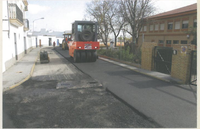
Asfaltado de la Avda. de las Marismas junto al Colegio Público
