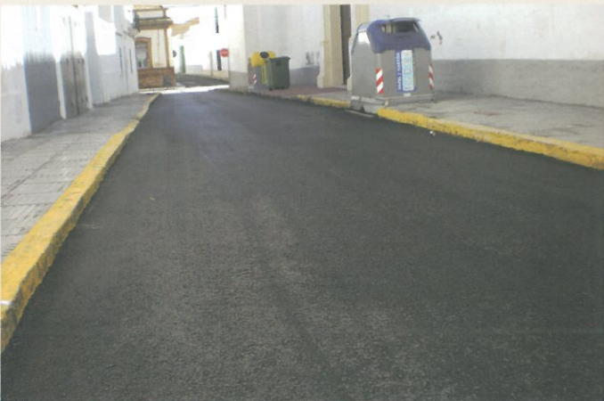
La Plaza de los Toros también ha sido asfaltada tras la culminación de las obras del nuevo acerado
