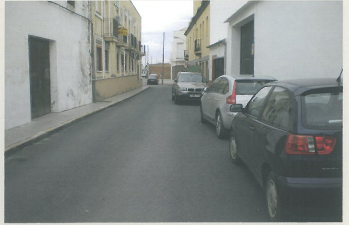
Asfaltado de la calle Odiel
