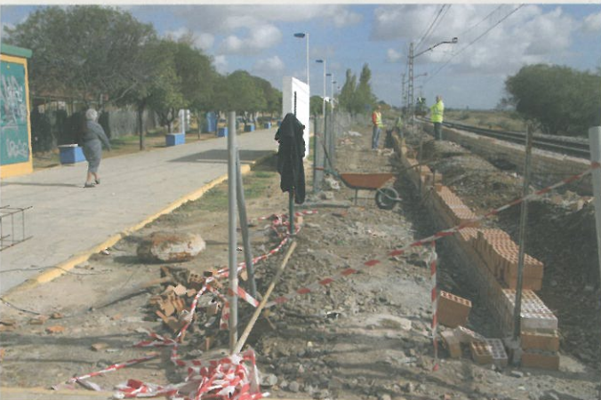
Operarios de ADIF ampliando el apeadero de San Juan del Puerto
