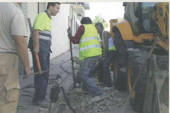
Los operarios trabajando en el primer tramo de las obras de acerado de la calle Huelva
