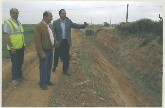
Visita del Delegado de Medio Ambiente a las obras de canalización de los arroyos tras las inundaciones
