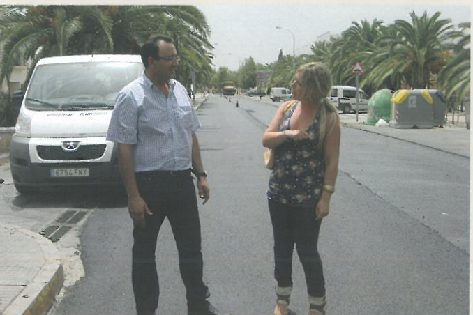
Obras en la Avda de Andalucía
