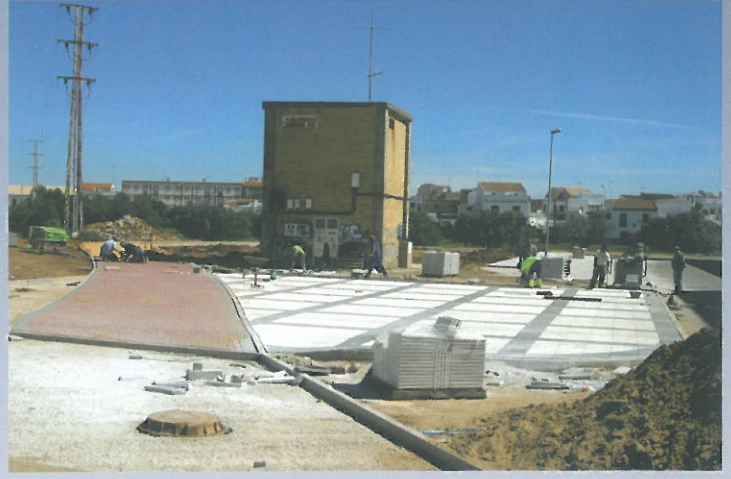
El Parque de las Fuentes se amplia con las obras que circundan por el Edificio Andalucía
