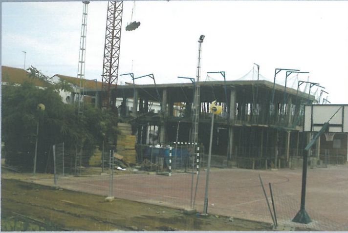
Obras de ampliación del Instituto de Secundaria Ldo. Rodríguez de Estrada
