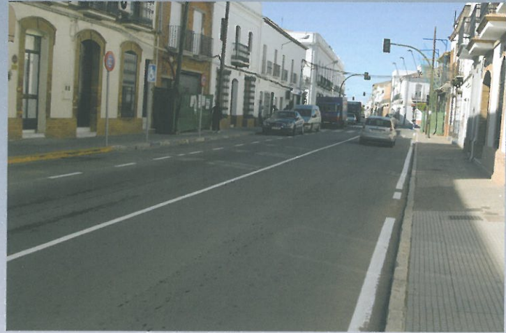
Las marcas viales de la carretera que cruza por nuestro pueblo fueron pintadas
