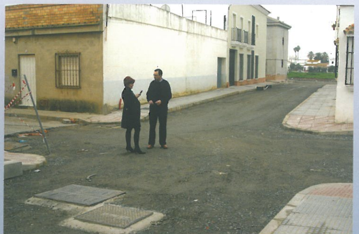
Las calles Rábida y adyacentes fueron asfaltadas a primeros del mes de enero
