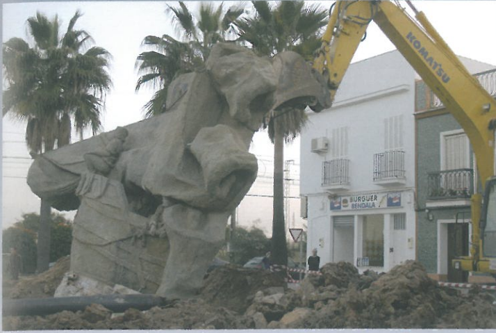
La Plaza de la Marina está siendo mejorada mediante unas obras de acondicionamiento
