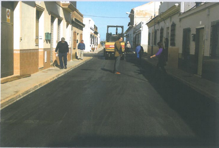
La Concejala de Obras Rocío Cárdenas junto a Felipe Prieto supervisó el nuevo asfaltado
