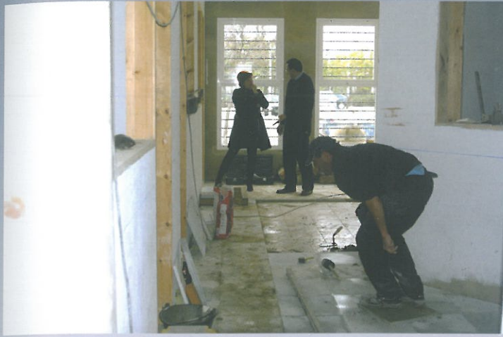
Obras del Vivero de Empresas Municipal en el Polígono Indutec
