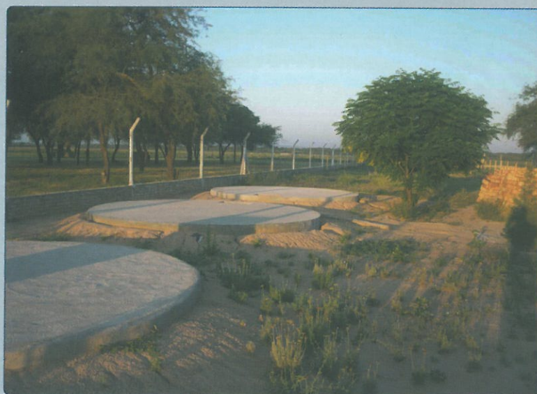
Fig. 2. Vista de detalle de los tres aljibes y estructuras de defensa. Gracias a la solidaridad del Ayuntamiento de San Juan del Puerto, todos podrán beber agua de calidad.
