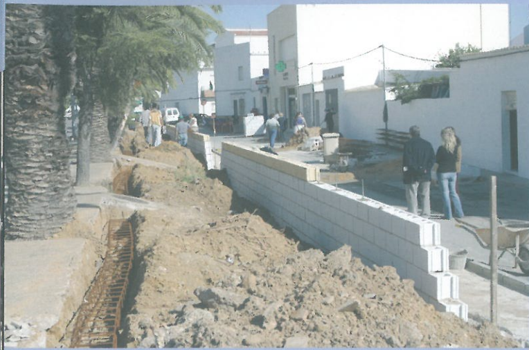
Las obras de acceso a la Bda. Juan Carlos I han concluido recientemente
