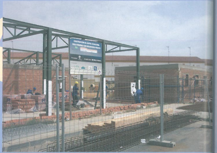
Las obras del Centro Ocupacional van a buen ritmo
