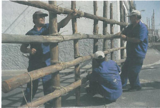
Operarios Municipales instalando las vallas en la calle Pozonuevo
