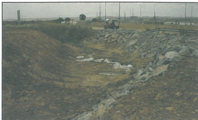
Las obras de mejora en el arroyo del Bregjillo, aliviarán uno de los grandes problemas de los vecinos del Prado de San Sebastián.
