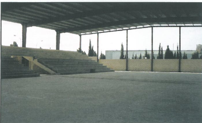
Instantánea que recoge una vista interior del Pabellón Polideportivo Cubierto que estamos construyendo en la Avenida Andalucía. Se recoge la pista polideportiva y parte del graderío
