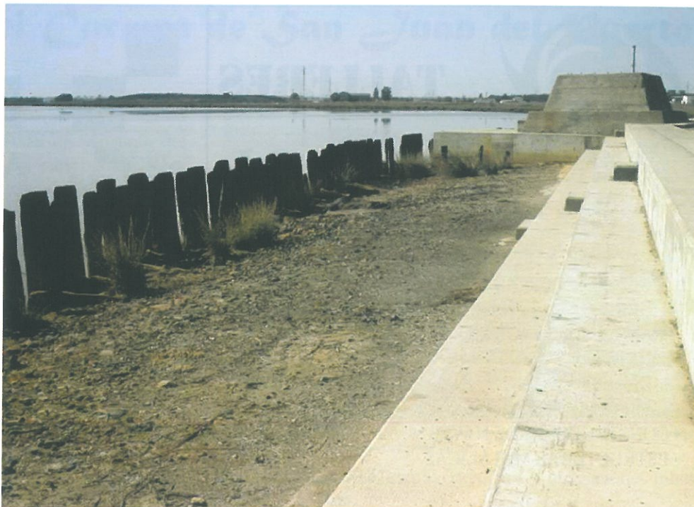
El "Muelle del Tinto" completamente restaurado
