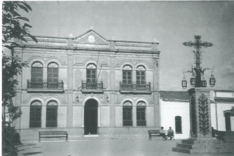
Instantánea de la Casa Consistorial antiguamente
