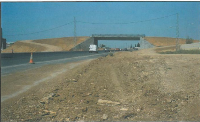
Puente elevado de acceso al Polideportivo Municipal
