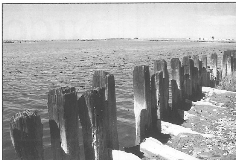
Uno de los espacios y lugares claves de San Juan del Puerto: el muelle y sus alrededores
