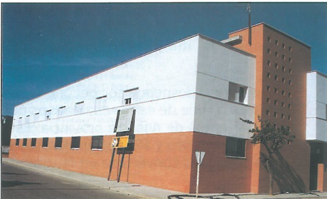
Terminación de las catorce unidades de viviendas construidas entre las calles San José, Paseo Marítimo y Santiago
