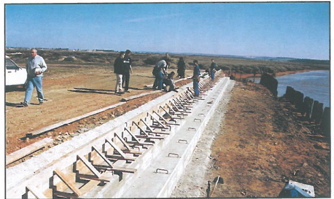
Obras de remodelación en Las Salinas y Muelle del Tinto
