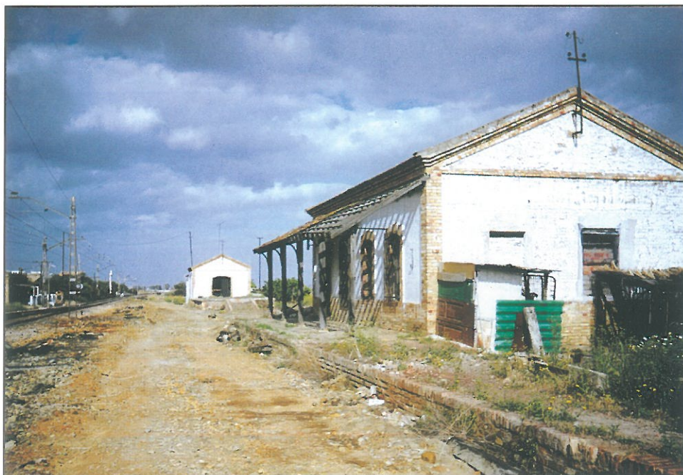
Estación y Casilla de la compañía de Riotinto en San Juan
