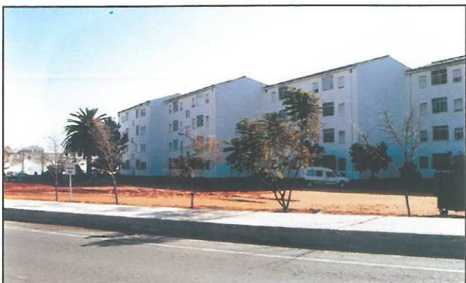
La demolición del antiguo silo de Trigo, y la construcción de una zona de parque y aparcamientos han dado una bella imagen a la Barriada de Celulosas
