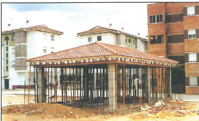
Estructura y cubierta del local, ya terminado e inaugurado de la Sede para la Asoc. de Vecinos de la Bda. Juan Carlos I - 2ª Fase, gemela de la Asoc. del Sagrado Corazón, también construida por el Ayuntamiento y recientemente inaugurada
