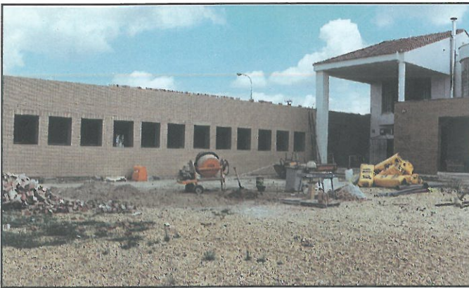
Terminación de las obras de ampliación del Instituto de Secundaria, con seis nuevas aulas
