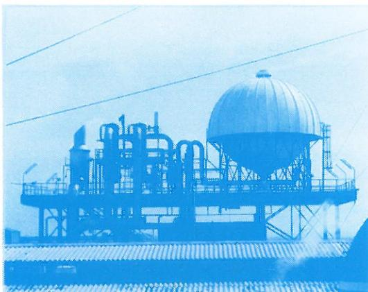
VISTA PARCIAL DEL SISTEMA DE ELIMINACION DE GASES OLOROSOS DE DIGESTORES.
