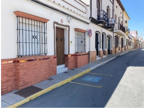
Plaza PMR sin señalización vertical. Inaccesible.
